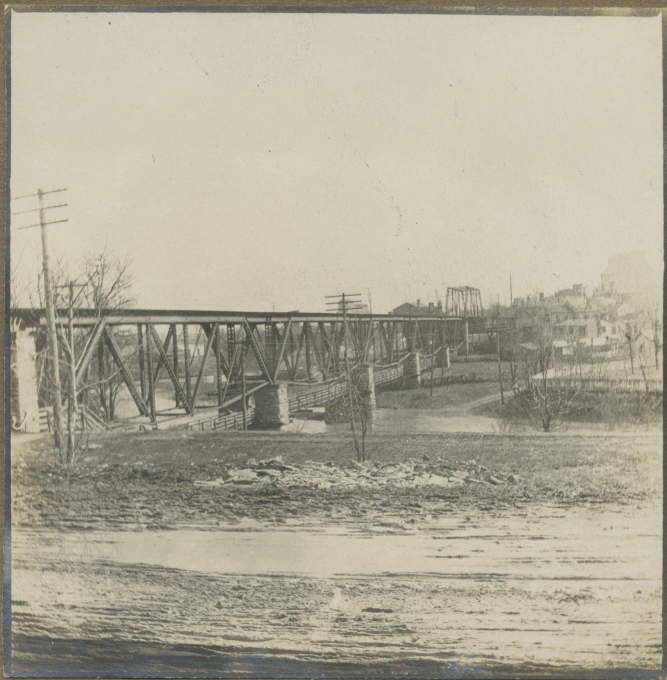
L. & N. Railroad Bridge.
